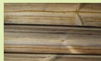
Fasádní obklad v průběhu procesu stárnutí (přirozené jsou nestejněměrné barevné změny).
